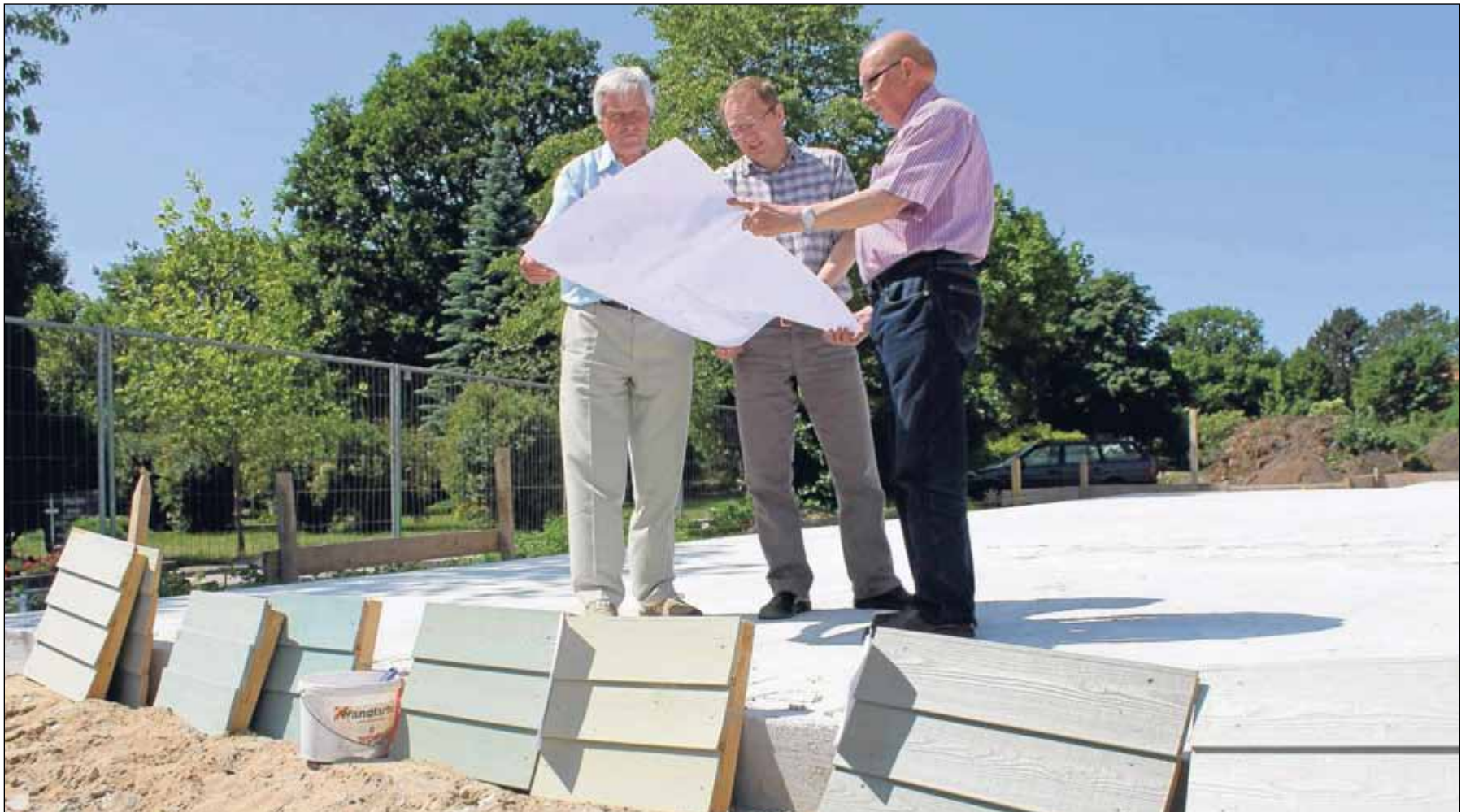
Die Umsetzung nimmt konkrete Züge an: Friedhofsverwalter Andreas Sterneck (Mitte) und der Verbandsvorstand des Friedhofs, Alminus Bleeker (links) und Dieter Waldmann, stehen auf der Bodenplatte des neuen Gebäudes, die Bauskizze in der Hand. Außerdem begutachteten sie die Farbmuster für die Außenoptik. Foto: Tenbrink
