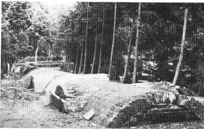
Gewölbe I—III, im Vordergrund Gewölbe III (Lohstötter)
