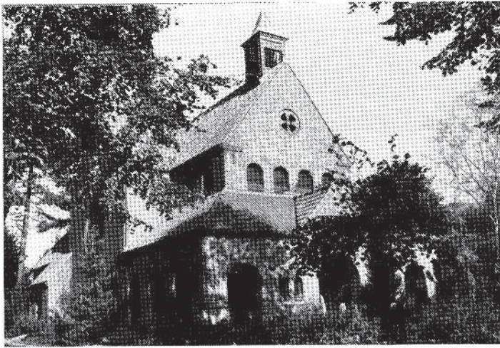
Friedhofskapelle. Ansicht von Südwesten
