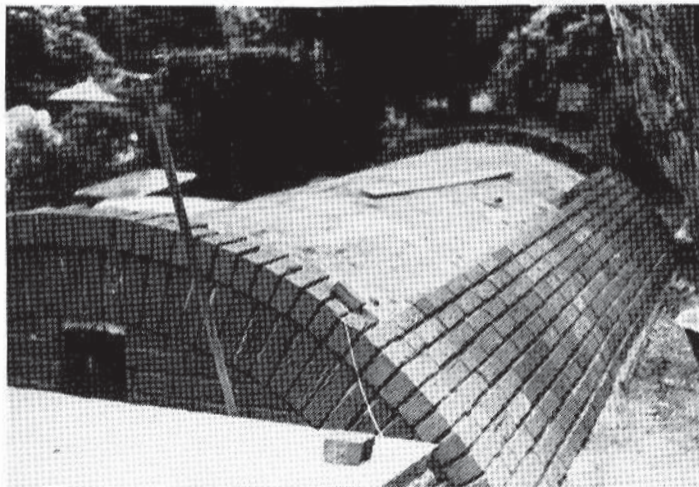
Gewölbe VI (Wagener), während der Restaurierungsarbeiten
